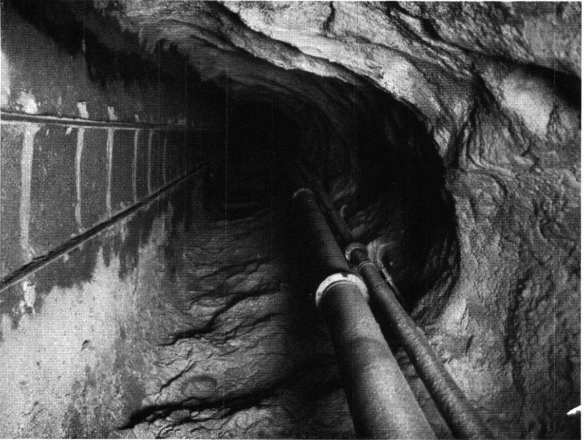
Fricktal: Versuchsstollen, gunitiert, mit Druckluft- und Ventilationsleitungen
