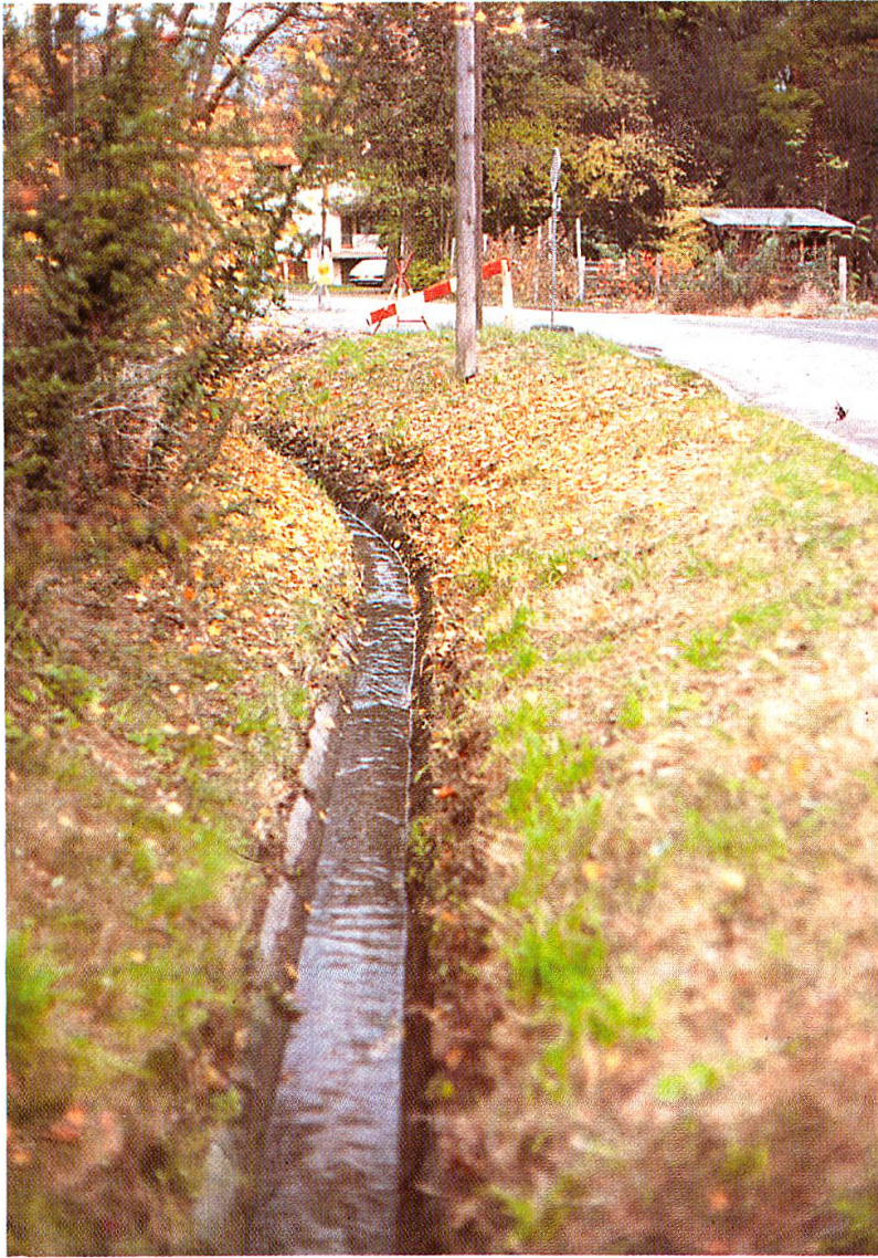
15 Rombach im Scheibenschachen- quartier
