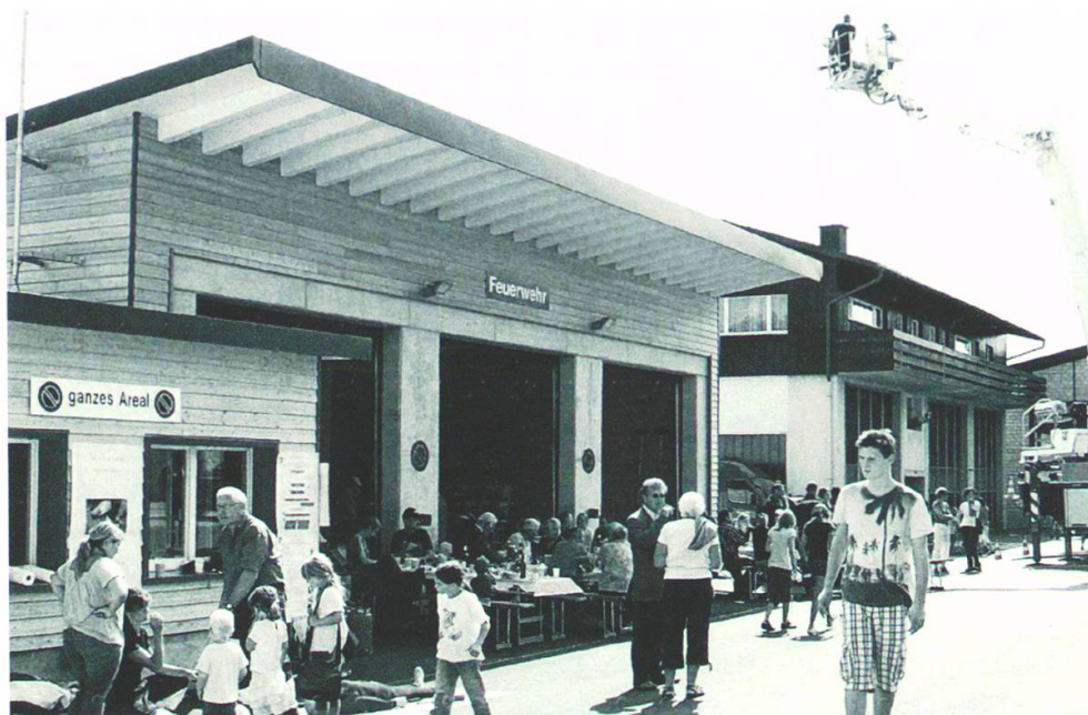
Das neue Feuerwehrdepot in Schönengrund, eingeweiht am 7. August.
