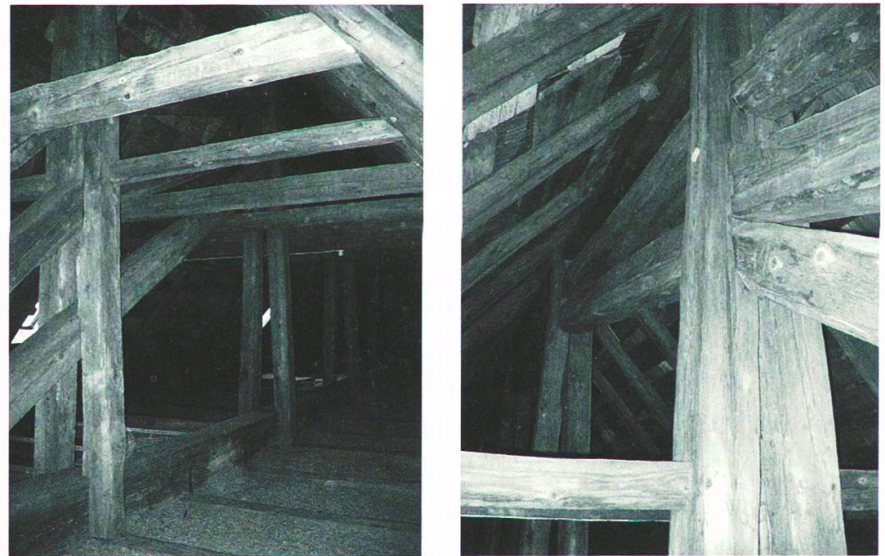
Abb. 13: Firstträger der Kirche Brunnadern (1763).
