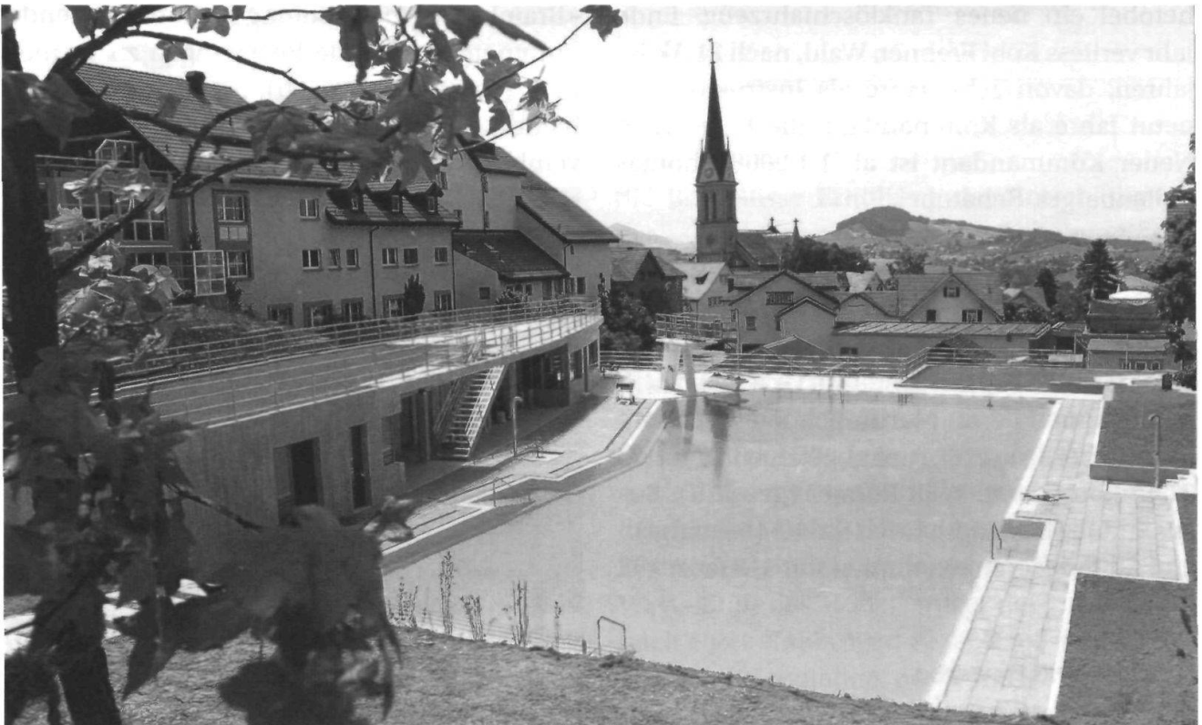
Das Schwimmbad wurde für zwei Mio. Franken renoviert und modernisiert.
