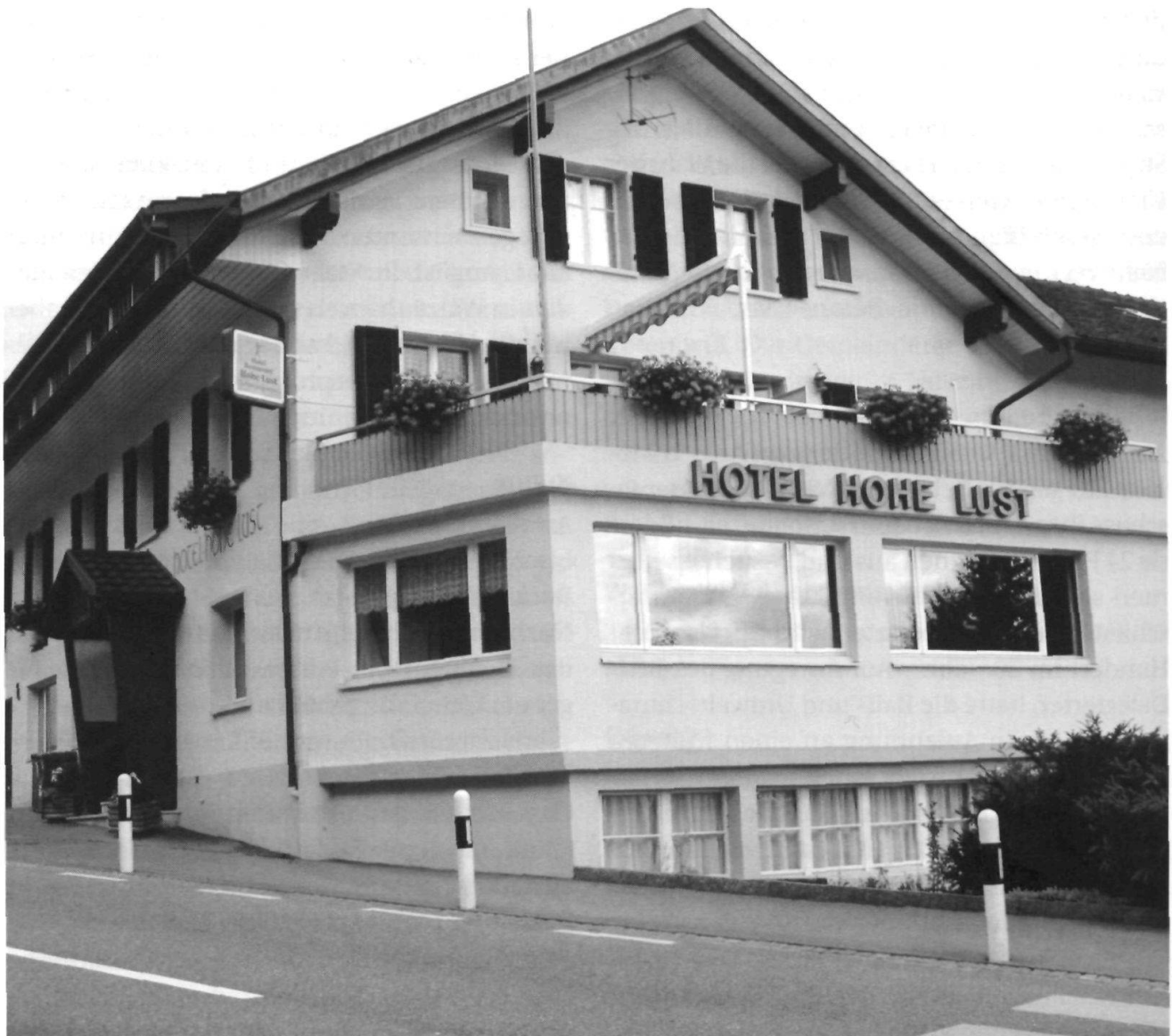
Das Hotel-Restaurant Hohe Lust nach der Aussensanierung.
