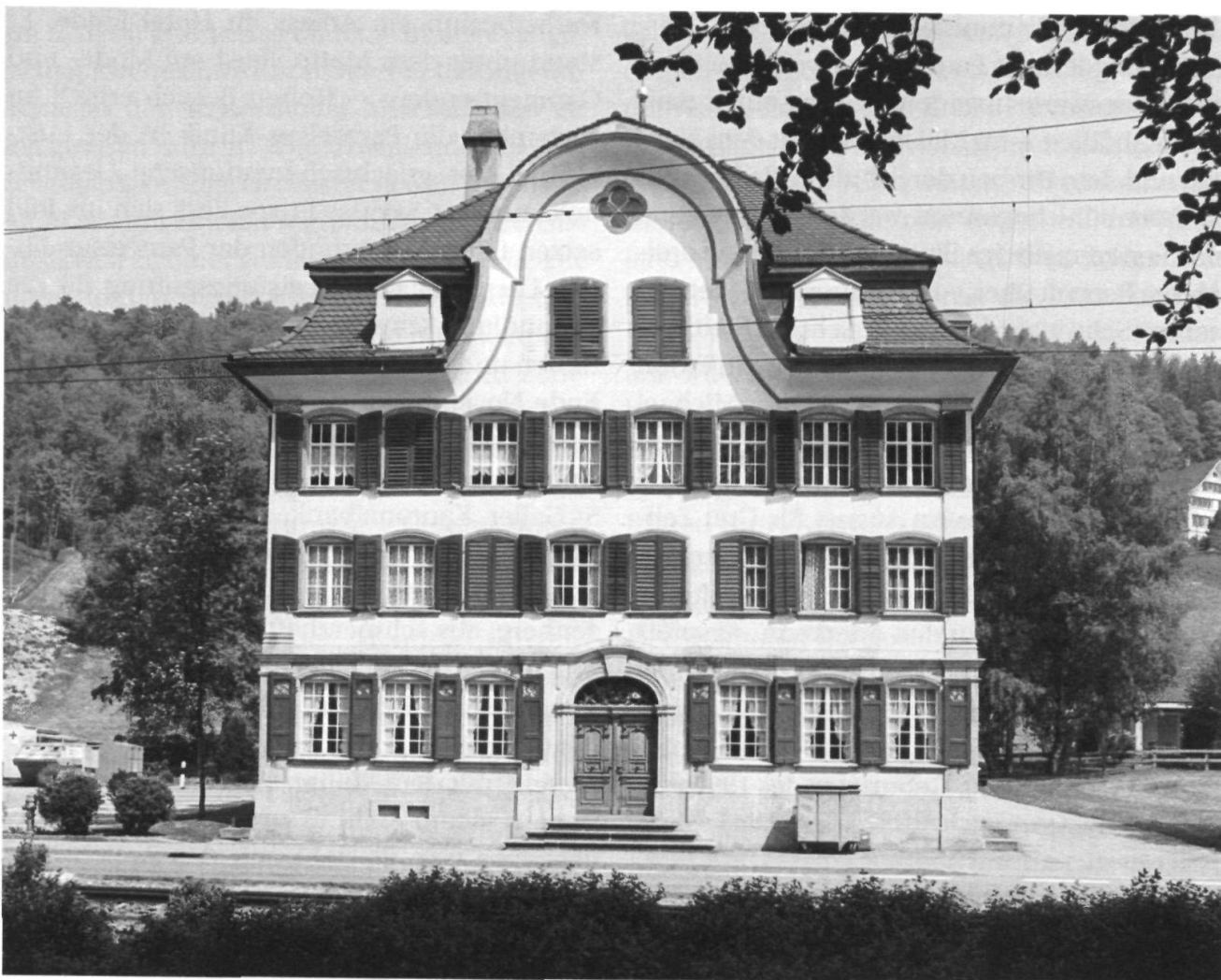
Das Böhlerer Türmlihaus beherbergt nun die Gemeindeverwaltung.
