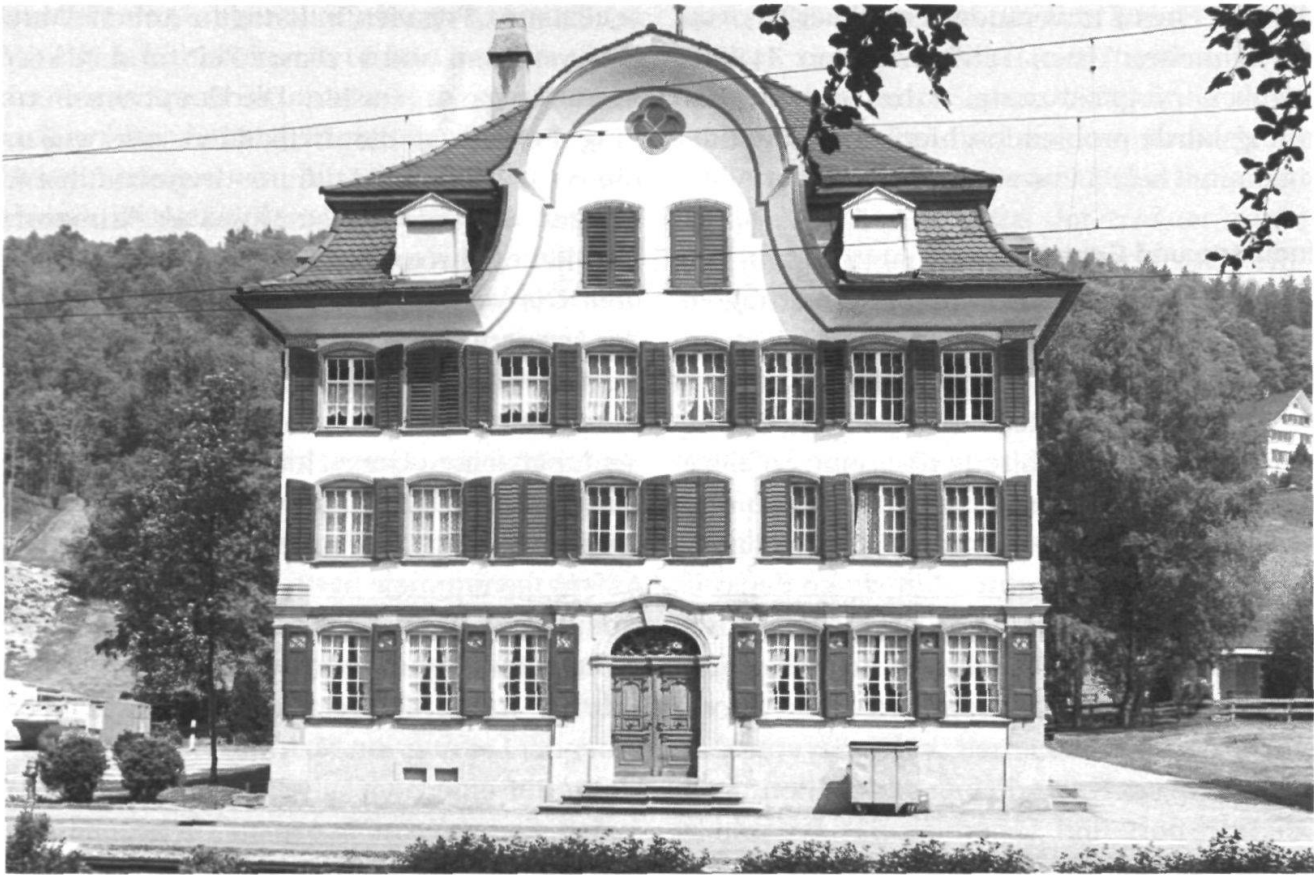
Das Türmlihaus kann nun für die Bühlerer Gemeindeverwaltung nutzbar gemacht werden.
