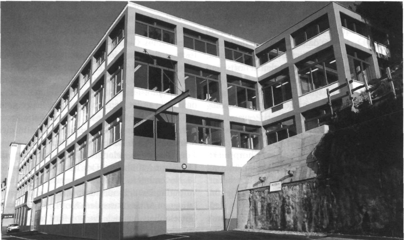
Im Nord nahm das Kunststoffwerk Hermann AG den für 4,5 Millionen Franken erstellten Erweiterungsbau in Betrieb. (Bild: P. Eggenberger)
