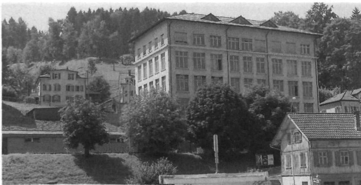
Das Geschäftshaus der zweiten Generation Buff, schon als Neubau mit Lift ausgestattet, überragt das Bahnareal Wilen.
