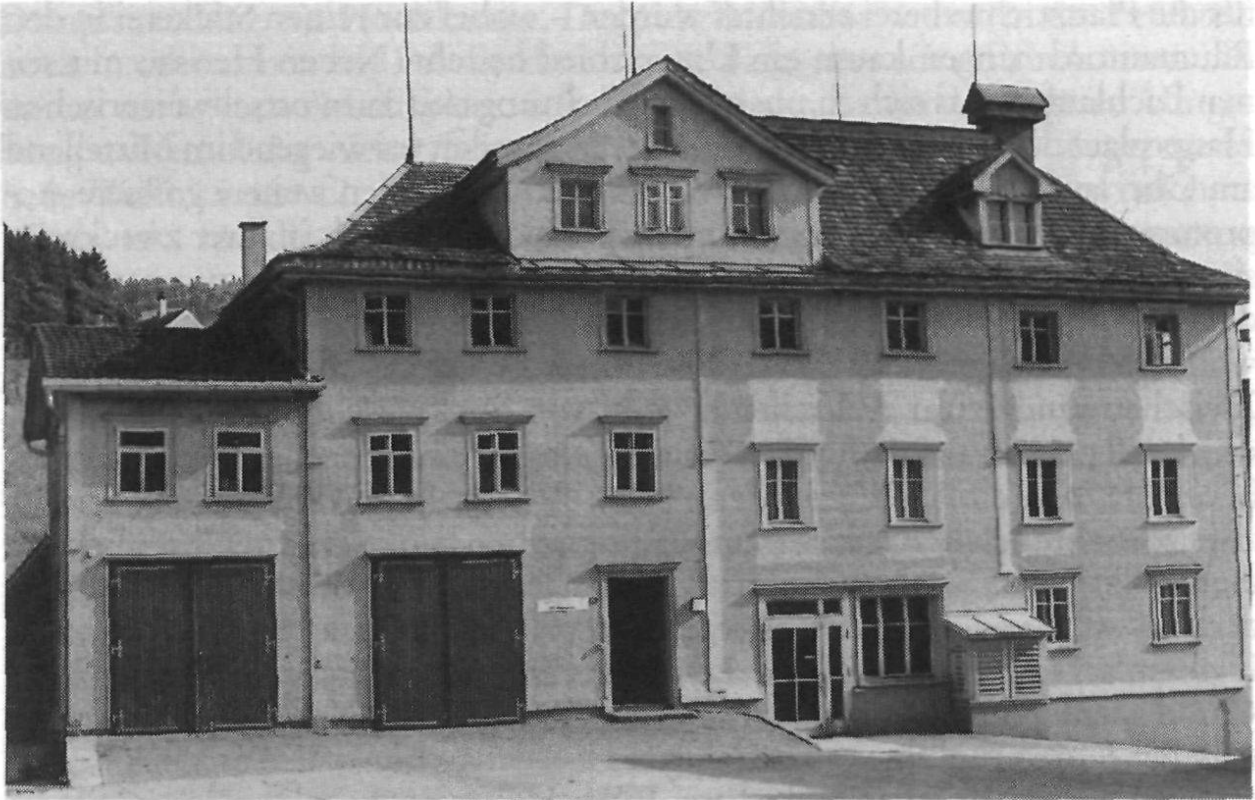
Die älteste Spinnerei für St.Gallen und Appenzell auf der Kantonsgrenze Wald/Schönengrund mit nachträglichem Anbau rechts und Aufstockung.
