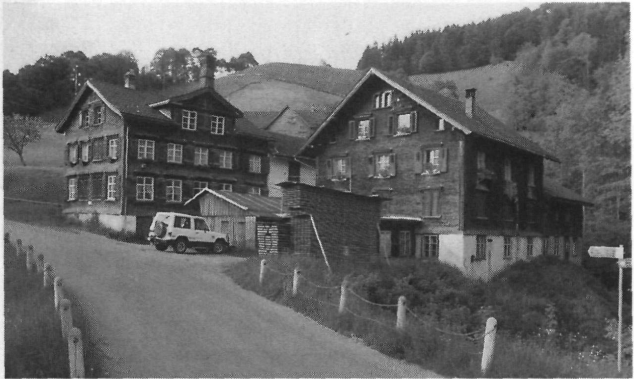
Parallel zueinander stehen Betriebsgebäude und Wohnhaus der einstigen Bleicherei, beide wohl im ursprünglichen Schindelkleid.
