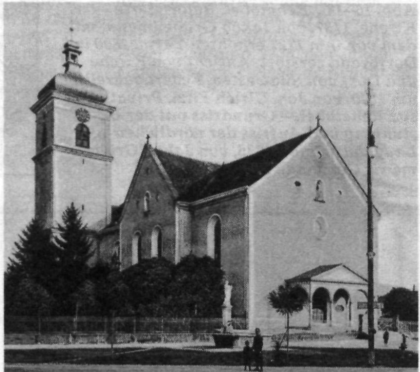
Abb. 14 und 15 Gossau SG. Katholische Kirche, 1732/33, von Jakob Grubenmann. Ansicht von Nordwe- sten im Zustand vor den Umbauten von 1925/26. – Querschnitt des Langhauses mit Dachstuhl samt Aufriss der Westempore.
