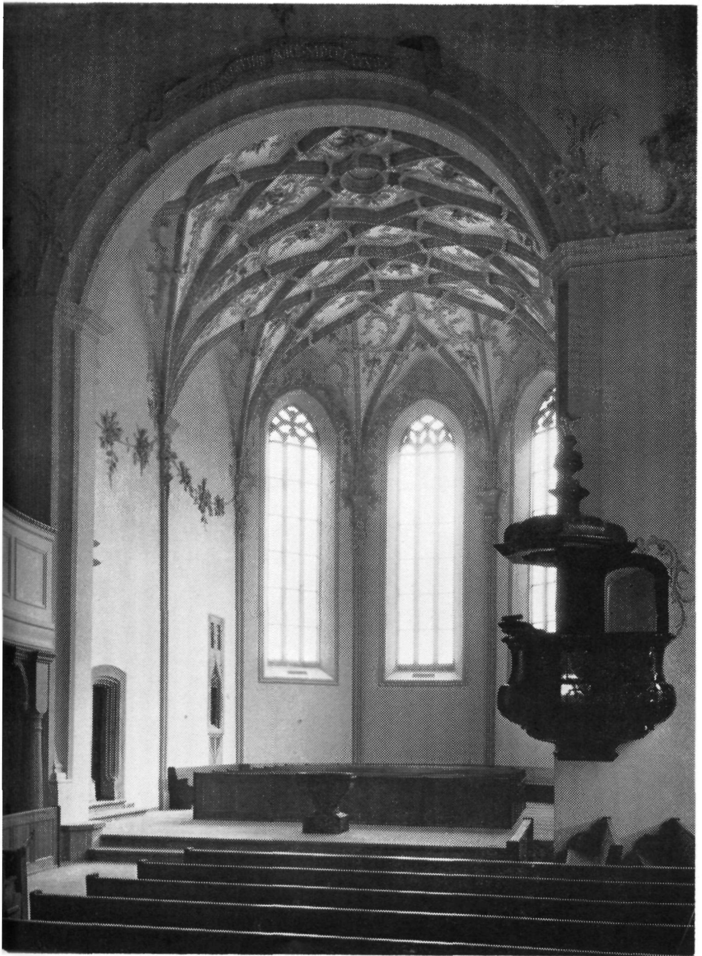
Herisau, das spätgotische Chor nach der Restaurierung von 1959/60 mit dem Netzgewölbe von 1516/20 und den Stuckaturen des Andreas Moosbrugger von 1782 (Jahrzahl am Chorbogen). An der östlichen Schildmauer das abgedeckte spätgotische Sakramentshäuschen. Kanzel und Taufstein aus stucco lustro von 1782.
