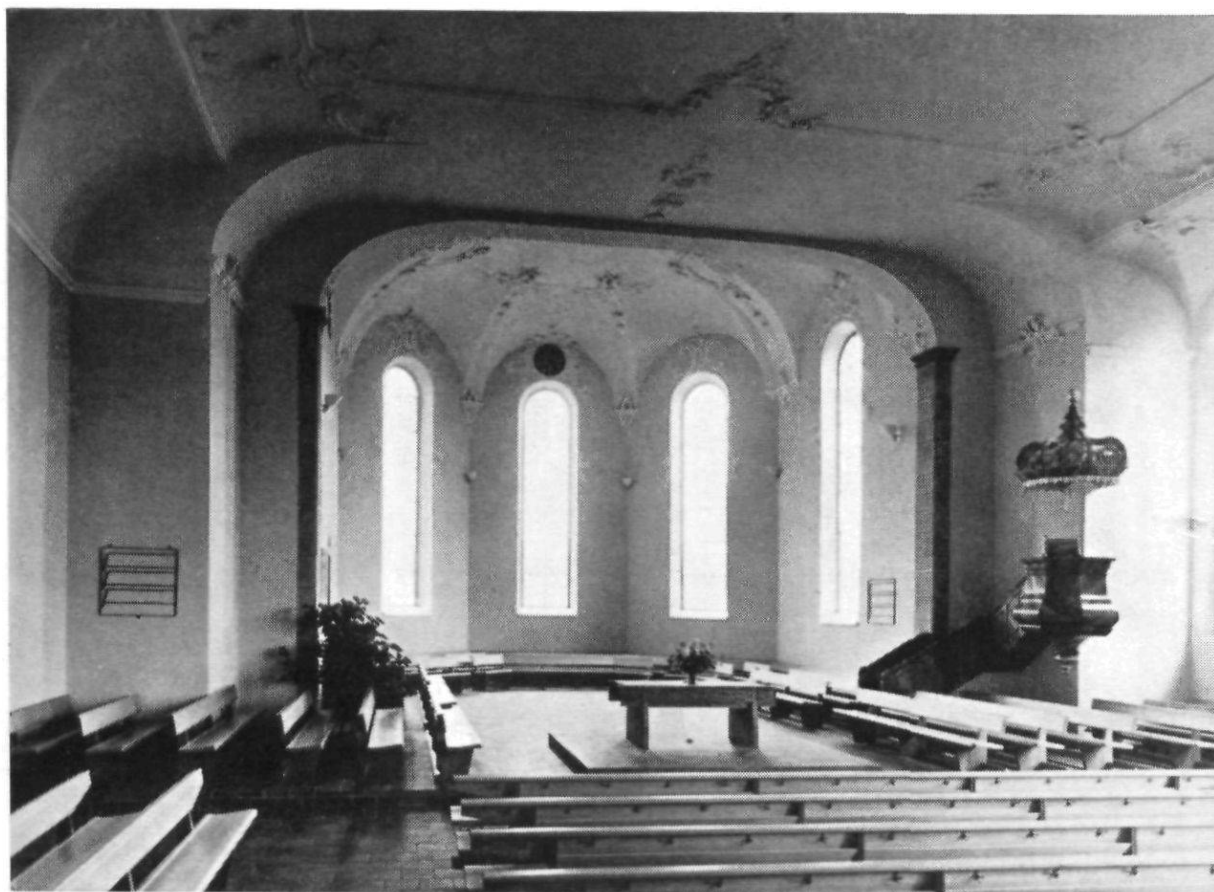
Teufen, das Innere gegen das Chor nach der Restaurierung von 1959/60 mit dem neuen Tonplattenboden und der neuen formschönen Bestuhlung.
