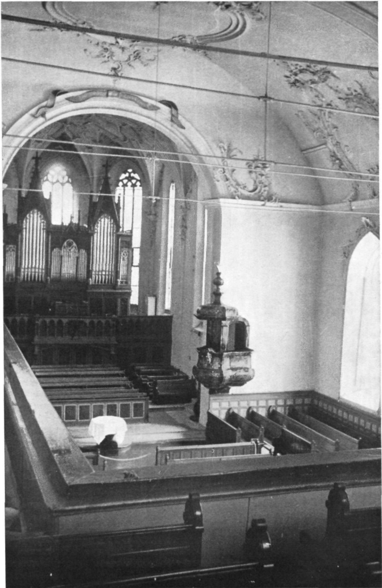
Herisau, das Innere vor der Restaurierung von 1959/60 mit der neugotischen Orgel von 1879, der alten Emporenbrüstung, dem Brusttäufer, der alten Bestuhlung und den Zugstangen.
