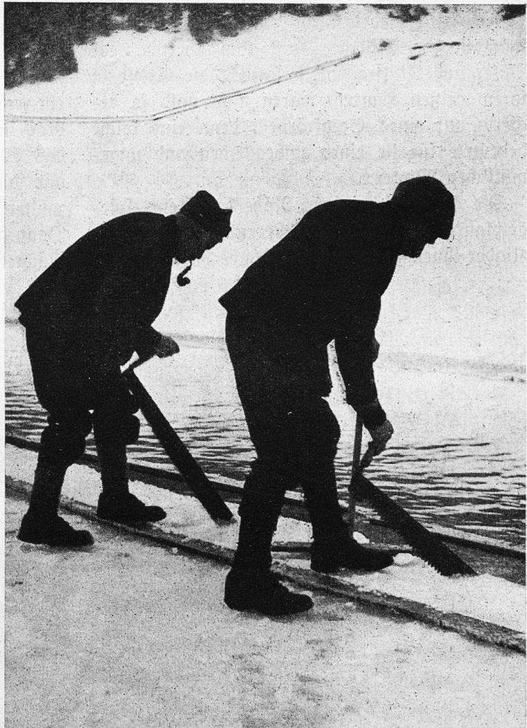
Das Eis wird in quadratförmige Blöcke zersägt
