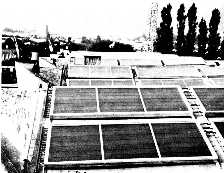
Flachkollektoren auf dem Tribürendach eines Stadions in Grenchen, die das Warmwasser für die Duschanlage aufbereiten. Gemäss verschiedenen Studien können pro Quadratmeter Sonnenkollektorfläche im Jahr mindestens 100 Liter Heizöl eingespart werden.
