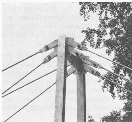
Bild 6. Pylonkopf mit Anschluss der Zugstangen
