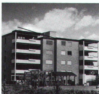
Foto: Peter Weber, BBI Bauberatung und Bauinformation
