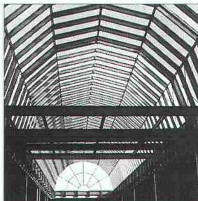
Hochbaukonstruktion (Unternehmensbereich Stahlbau)
