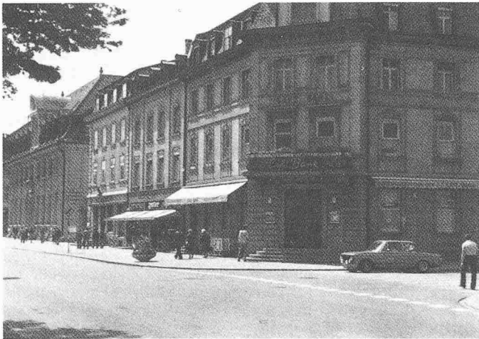
Beispiel Stadt (Aarau): Nicht nur die Altstadt ist schützenswert. Als parallele Bebauungsachse zur Laurenzenvorstadt, dem städtebaulichen Zeugnis aus der ersten Hälfte des 19. Jahrhunderts, entstand in der zweiten Hälfte die Bahnhofstrasse. Mit ihren monumentalen Bank- und Verwaltungsgebäuden, mit den Schulen und Kasernenbauten ist sie mit Abstand die eindrücklichste Bebauungsachse im ganzen Kanton aus dieser Zeit
