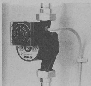
4-Gang-Schaltung von Wilo. Sie ist in etwa einer Stunde am Einbauort der alten Pumpe installiert. Wenn bei Reparaturen oder Änderungen an der Heizung ohnehin das Wasser abgelassen wird, kann auch gerade diese Sparmassnahme vorgenommen werden.
