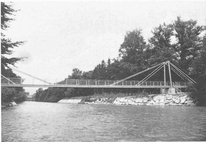
Bild 2. Ansicht des Steges von Oberwasserseite
