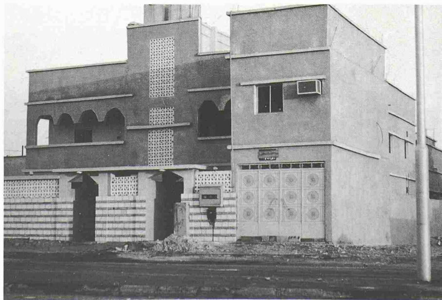
Beispiel lokaler, «moderner» Architektur
