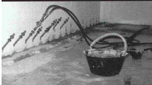
Elastische Abdichtungs-Injektion-Rascolflex in einer Zivilschutzanlage.
