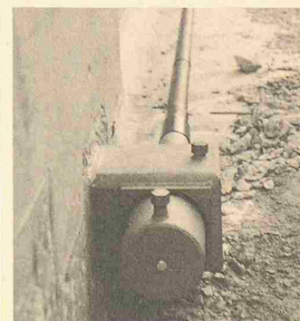
Bild 4. Die Verankerungen der externen BBRV-Spannkabel liegen auf quer zum Träger eingebauten RHS-Profilen
