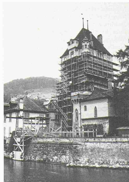
Schloss Oberhofen am Thunersee: Renovation (Bild: Comet)
