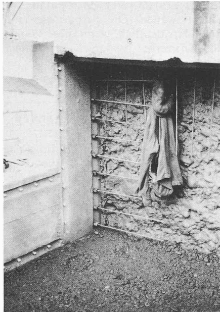
Bild 4. Freigelegte Ankerköpfe und bereits gekoppelte Armierung
