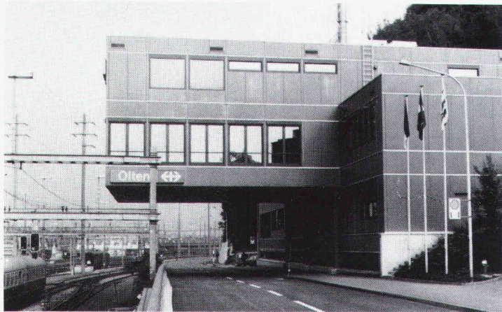
Neues Stellwerk Bahnhof SBB, Olten, Fahrbahnisolation
