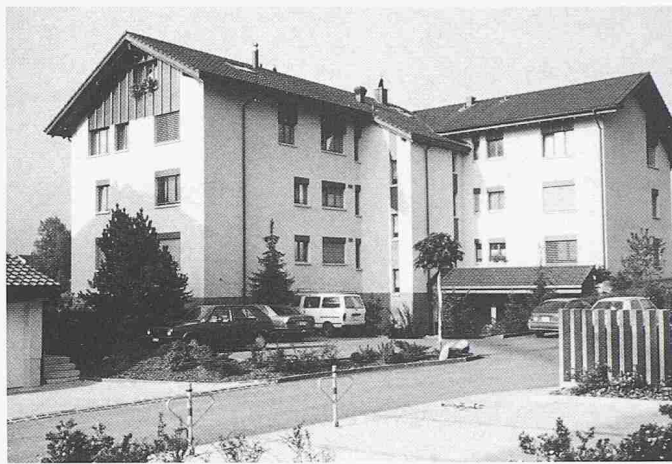
Mehrfamilienhaus Rietwies, Sonnenriedstrasse 6, Wangen; Architekten: Eggenberger & Schättin AG, Wangen SZ
