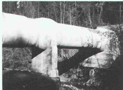
Düker Rempen, Kraftwerk Wägital AG
