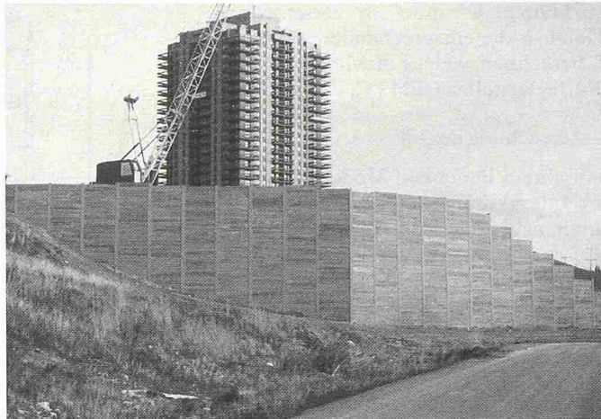
Stützkonstruktion verstärkt mit Geogittern, Front mit Holzelementen, Calgary (Alberta)
