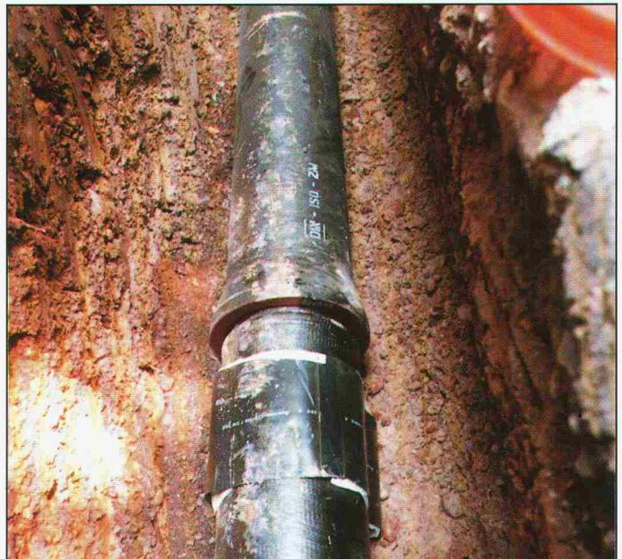
Die Muffenverbindungen werden bei FZM-Gussrohren entweder mit Gummimanschetten, oder mit Raychem-Schrumpfschläuchen geschützt. Im Bild hat der Verleger den Schrumpfschlauch vor dem Erstellen der Verbindung auf das Spitzende aufgezogen und wird ihn nun in einem zweiten Arbeitsgang über die Muffe ziehen und dort schrumpfen. Deutlich erkennt man die aggressiven Bodenverhältnisse im Grabenbereich, vor denen der FZM-Panzer das Gussrohr auch ohne Kieskoffer zuverlässig schützt.
