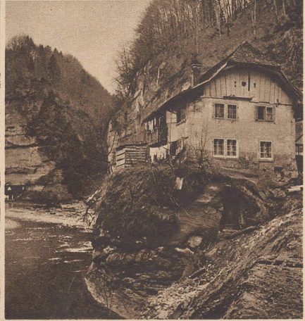
Einige hundert Meter in Luftlinie vom Bahnhofplatz und von seinem pulsierenden Verkehr entfernt, träumt dieses alte Haus mit seinem Felsenkeller am Wasser.
