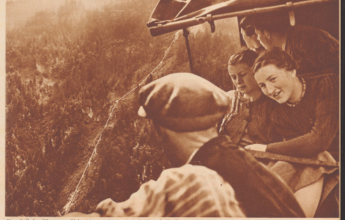
Eine Seilbahn führt vom Elektrizitätswerk zur Bannalp hinauf. Sie dient weniger dem Personentransport als dem Materialtransport und trägt ein Wachen gewichtig Mengen Zement zum Abdichten des Beckens in der Höhe, nennt aber nach breittätig Touristen mit. Zur Linken sieht man die Druckleitung vor sich, ein submergiertes, überlängtes Rohr von 53 cm Durchmesser, das sich an die mehr verklüftete Nidwalden Klammern und ein Gefälle von 700 m überwindet. Ein Invasionskonstrukt der Station elektrische an lac. Ses principaux clients sont actuellement des sacs de ciment. A gauche on aperçoit la conduite d'eau qui du lac: il faut en faire une démolition de 700 mètres.
