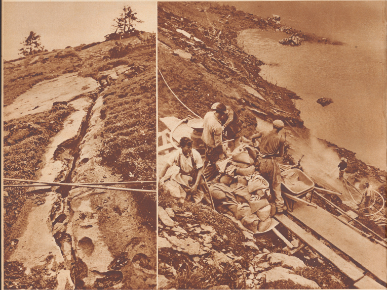
Semblable à une longue blessure, voici l'une des fissures par où l'eau du lac.
