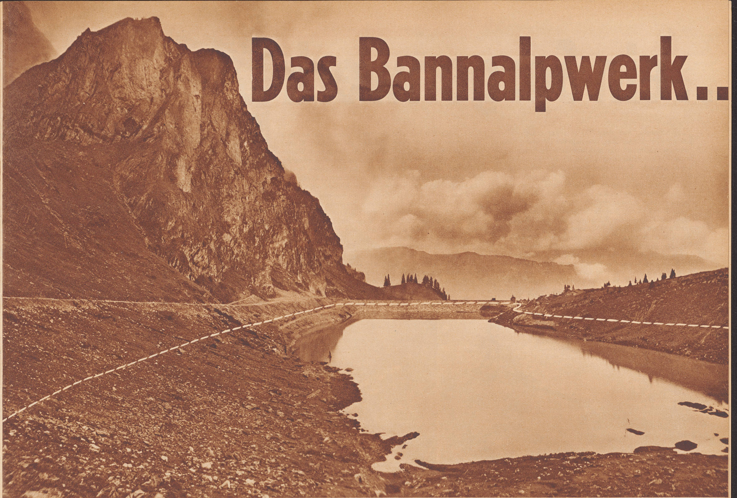
Der Bannalpsee am 18. Juli 1938. Die eingezeichnete Linie zeigt die beabsichtigte Stauhöhe von 16 Meter. Der Staudamm im Hintergrund, dessen Kosten mehr als 1 Million Franken betrugen, enthält einen Lehmkern und ist zur Seeseite hin von einer Steinverkleidung umgeben. Der Bach, der die Wasser der Rigidalstöcke, des Ruchstocks und des Kaiserstuhls mit sich trägt, wurde bis zum 1. Juli, da die neue Stauung begann, unmittelbar in die Druckleitung geführt.
