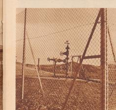
Die Ölfeldentwicklung bei den zwölf Pumpstationen entlang der Leitung erfolgte durch diese einfache Apparatur, die zum Schutz gegen Überhitzung mit einem Dreifachen umhüllt ist. Préparation. Les régulateurs de pression sont protégés par d'épais treillis de fil de fer.
