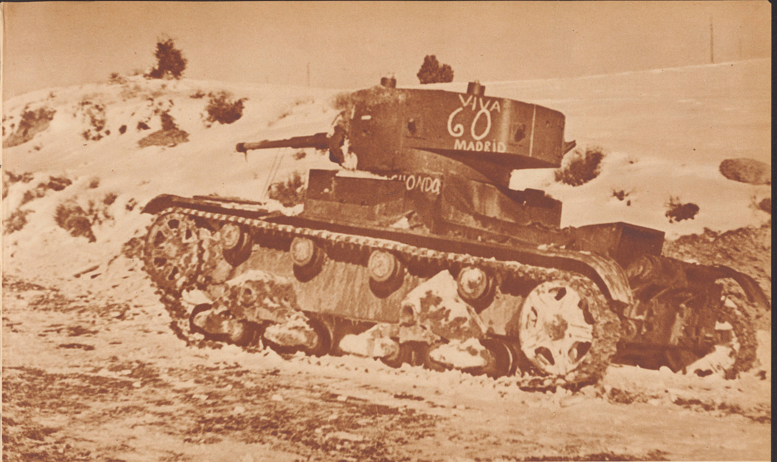
Kampfwagen der Regierungstruppen vor dem Dorfe Conclud. Er steht nicht deshalb untätig am Straßenrand, weil er im Schnee stecken geblieben ist – denn Schnee ist kein Hindernis für Tanks, – sondern er mußte «beiseiterreten» weil eine Proviantkolonne vorbeiging. Aux environs de Conclud. Un tank gouvernemental s'est rangé sur le bas côté de la route pour laisser le passage à une colonne de ravitaillement.
