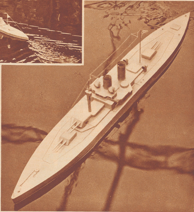
Das Schiffsmodell wird von dem jungen Manne auf der Treppe des Wasserbassins ferngesteuert. Rechts von ihm steckt in dem Kofferchen der Telegraphie-Sendeapparat. Vor dem Manne steht die 4 Meter lange Sendeantenne. Er hält in der Hand eine Telefon-Nummernscheibe. Je nach der Nummer, die er einstellt, bewegt sich das Schiff vor- oder rückwärts, langsam oder schnell.
