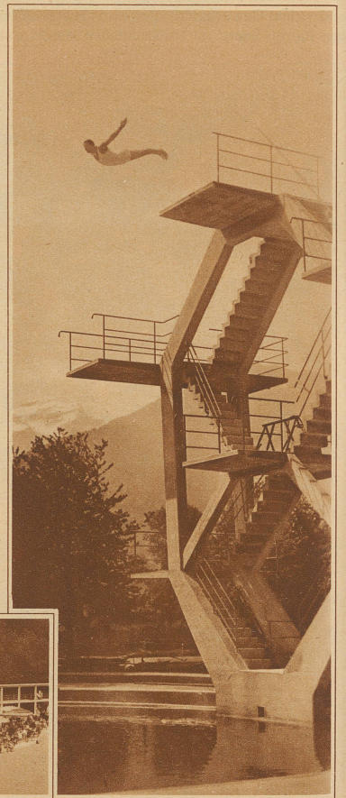
Der nezeitliche Sprungturm aus armiertem Beton. Im Hintergrund die «Schwalmern»
