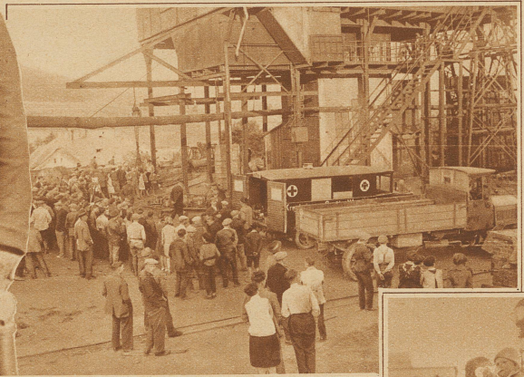
Vor dem Eingang des Kurt-Schachtes, durch den die Rettungsmannschaften in die Tiefe stiegen
