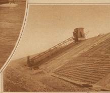
An dieser Stelle hat der Kanal eine Tiefe von 12 m und eine Breite von 150 m. Die Stauwehre werden mit einer Spreitmaschine leicht betont
