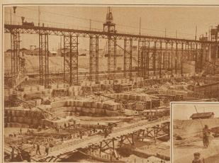
Links oben: Blick auf die Baustelle, wo die 6 Turbinen zu je 33 000 P.S. eingeführt werden. Das Eisengerüst dient als Betonunterstützung
