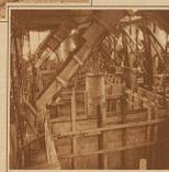
Verschaltungsarbeiten für die Wehrfelder des Stauwehrs bei Markt
