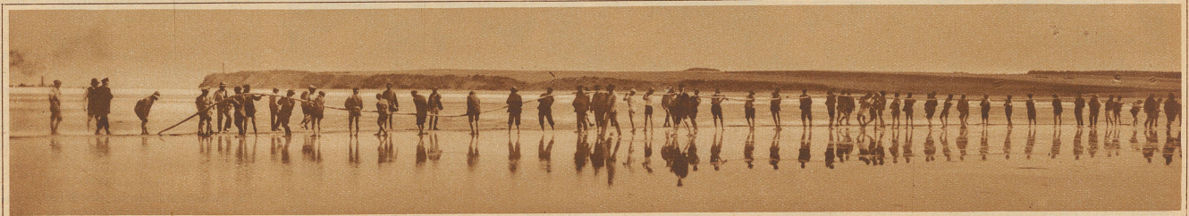
Ausschleppen des längsten See-Fernsprechkabels der Welt, das zwischen Finnland und Schweden gelegt wurde
