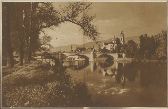
Die neue Brücke in Solothurn. Sie wurde als Notstandsarbeit mit einem Kostenaufwand von 1,300,000 Franken ausgeführt
