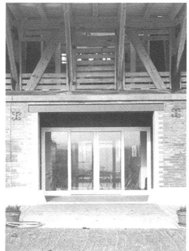
Riedernstrasse 40, 40 A: Neue Fassadengestaltung im ehemaligen Stallteil.
