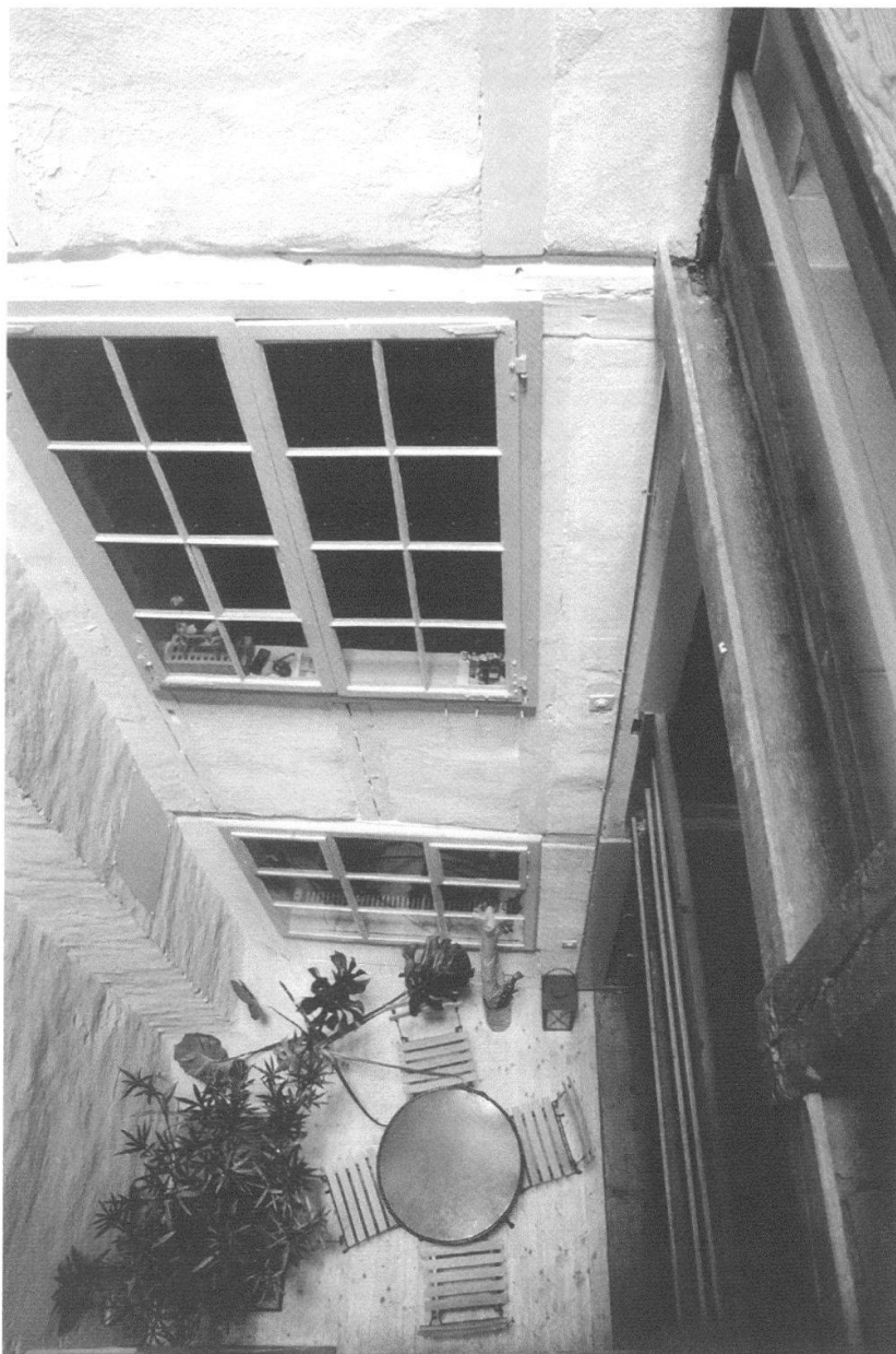
Schiffлаube 32: Inliegender Treppenhausthof mit Fassade des Gassen- hauses und seitlichen Verbindungsgalerien.
