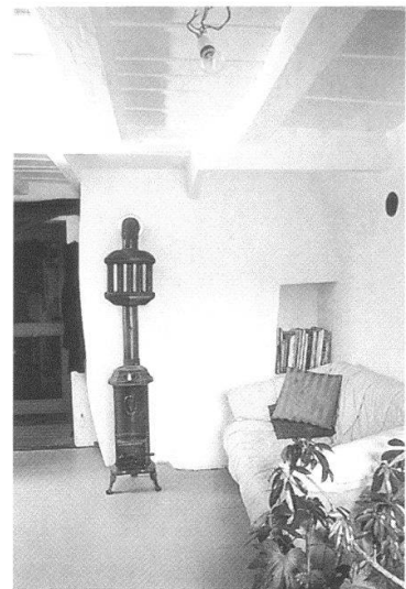
Alpeneggstrasse 10: Umgenutzte Küche im Südteil mit Etagen- holzfeuerung und ablesbar erhaltener Rauchhütte.
