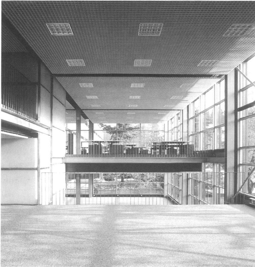
Weltpoststrasse 17: Innenraum vor und nach dem Umbau.
