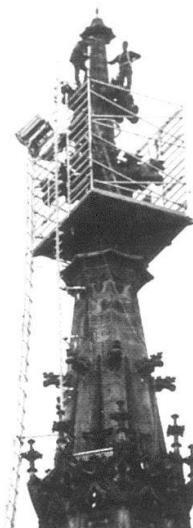
Berner Münster: Die Turmspitze während der Sicherungsarbeiten.
