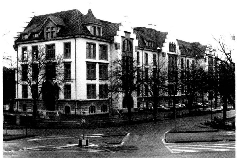
Das Spitalackerschulhaus nach der Sanierung.
