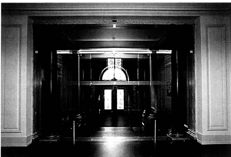
Hochschulstrasse 6: Gesamtansicht Eingangshalle nach der Restaurierung.
