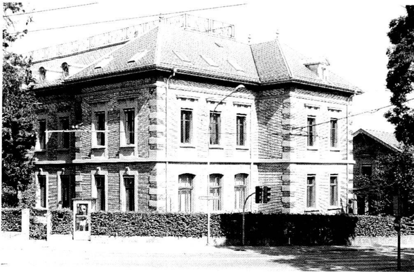
Uni Engenhalde: Sicht vom Henkerbrännli auf das ehemalige Administrationsgebäude.
