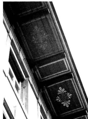
Schulhaus Kirchenfeld: Die Untersichtmalereien. Oben das restaurierte Belegfeld, unten die Neufassung.
