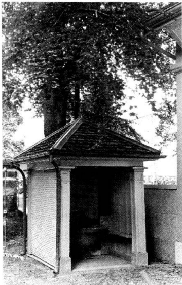
Laupenstrasse 49: Renoviertes Sodbrunnenhaus nahe des stadtseitigen Zugangs an der Laupenstrasse.
