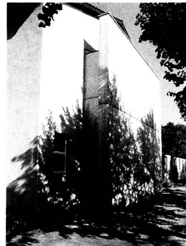
Abdankungskapelle Schosshaldenfriedhof: Die zurückverschobene Chorwand von aussen.
