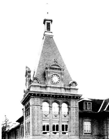
Viktoriaschulhaus: Der restaurierte Turmhelm.
