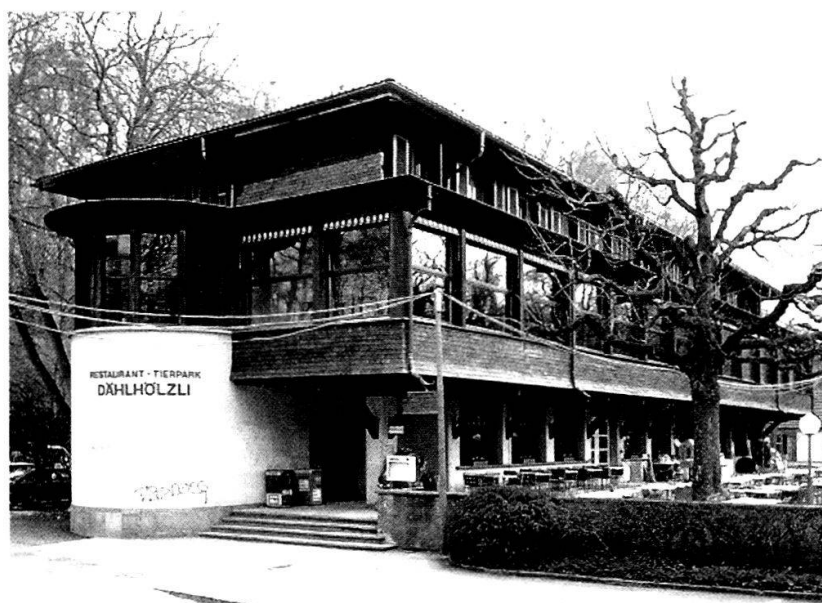
Tierparkweg 2: Das Tierparkrestaurant nach dem Umbau.
