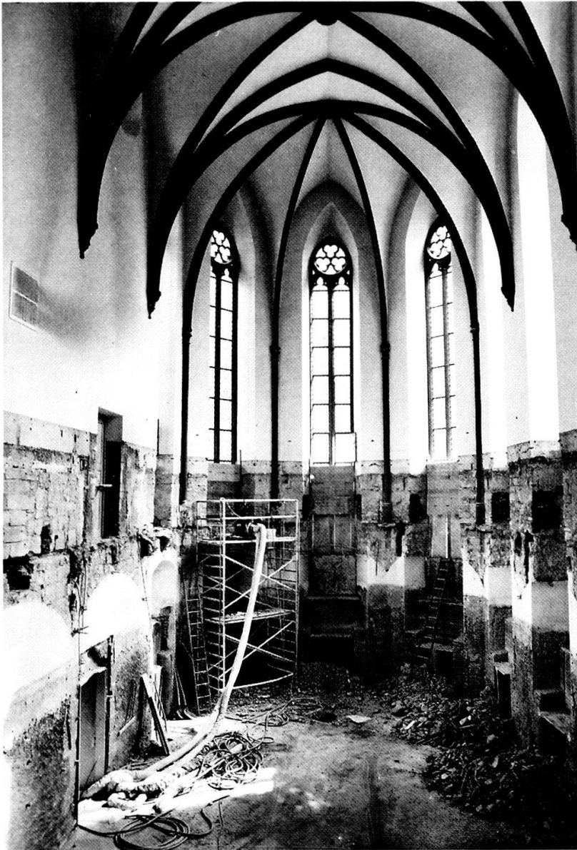
Chor-Raum der Französischen Kirche nach Abbruch des Zwischenbodens.
