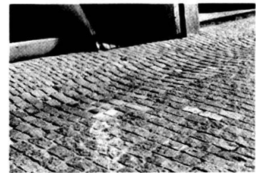
Postgasse: neue Pflasterung von 1981/82.
