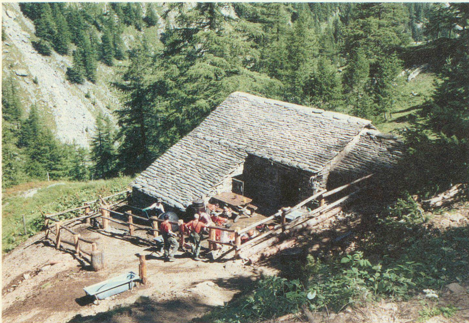
Das Gelände ist wieder gesichert – dank dem Zivilschutz.
