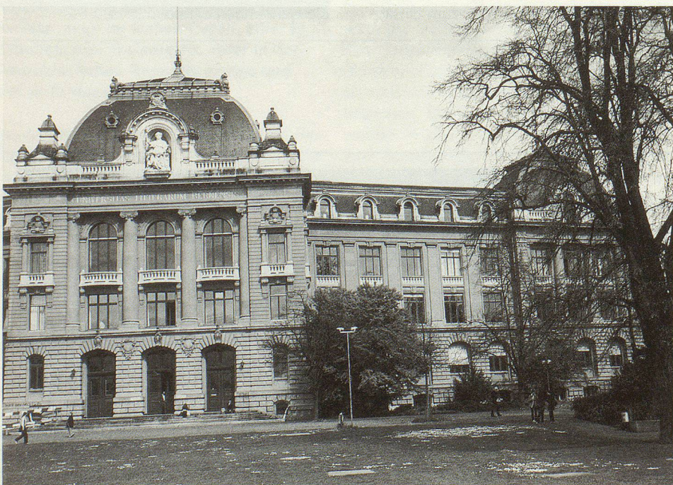
Das Hauptgebäude der Universität Bern.
