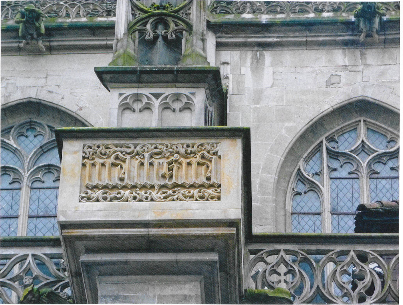
Abb. 9 Bern, Münster St. Vinzenz, Nordfassade, zweiter östlicher Strebepfeiler, Laufgangbrüstung mit Sinnspruch «machs na», von Erhard Küng, nach 1483 (?).
