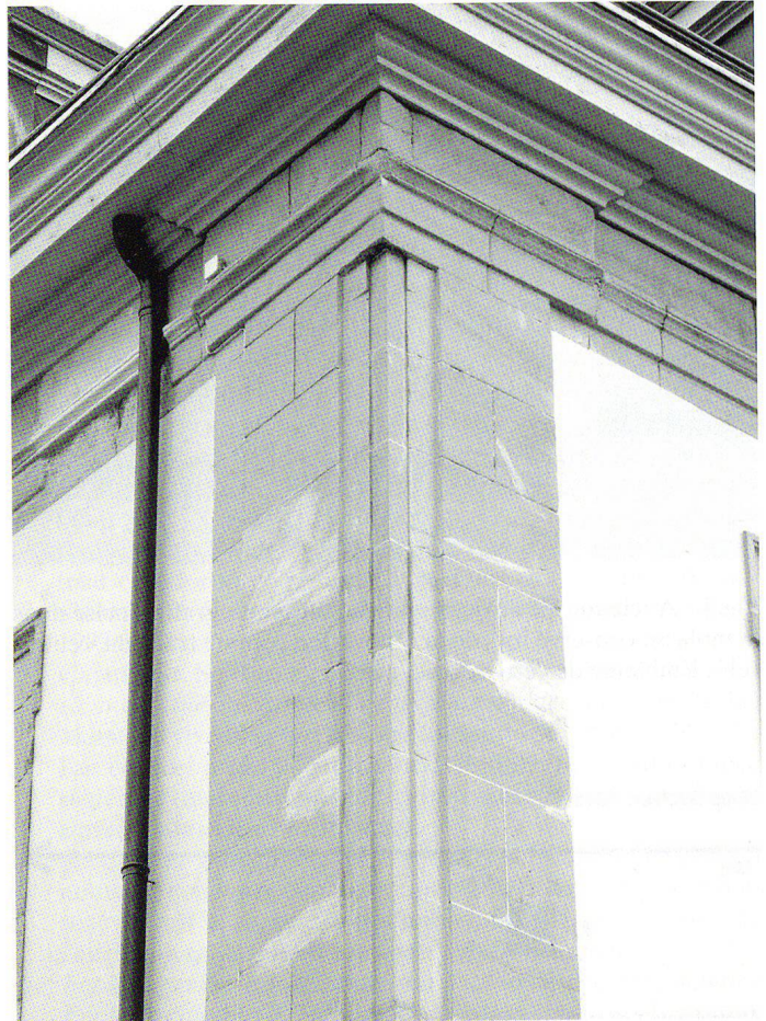
Fig.6 Ancienne Ecole de chimie de Lausanne, détail d'une chaîne d'angle après « rénovation douce ».
