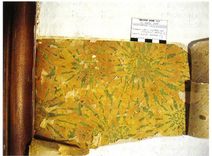
Fig. 11 Sondage mettant au jour le papier original du plafond de la salle à manger du premier étage.
